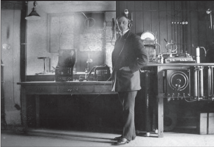
SAE Tingståde Gniststation i början på 1910-talet med AEG 8 kW gnistsändare enligt system "Tönende Funken" (Tingståde Hembygdsförenings arkiv).
